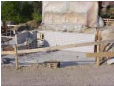
1. Baugrube mit Fundament und Kellermauer.
