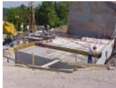
5. Einlegen der Armierungseisen und Elektrokabel in die Kellerdecke.
