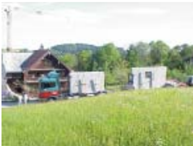
2. Die ersten Betonelemente kommen.
