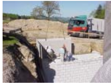
4. Millimetergenaues Setzen der Betonelemente.
