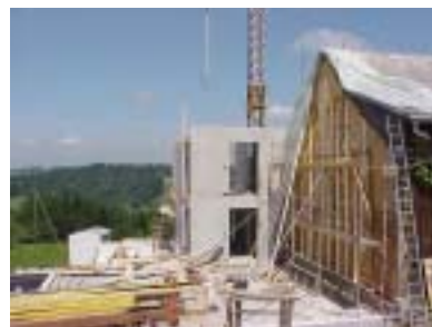
6. Das Treppenhaus steht.
